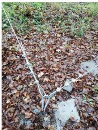
Rysunek 29. a, b. Łączenie kotew linowych i lin odciągowych [fot. W. Błaszczyk]
