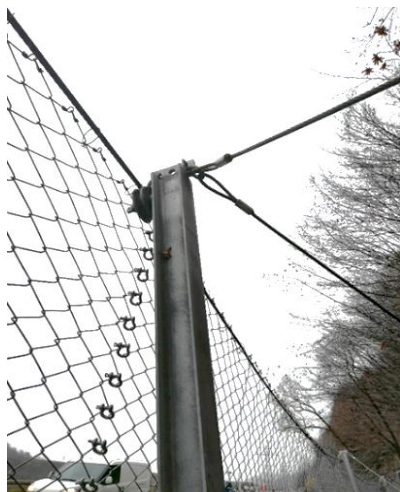
Rysunek 28. Łączenie słupka z linami odciągowymi [fot. W. Błaszczyk]
