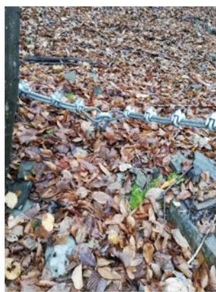
Rysunek 29. a, b. Łączenie kotew linowych i lin odciągowych [fot. W. Błaszczyk]
